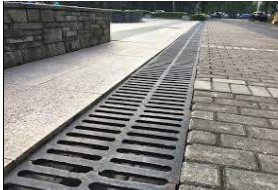
Limpeza de elementos de drenaje superficial y de recogida de aguas de lluvia (Se realizará la limpieza de los residuos que se encuentren sobre estos elementos)
